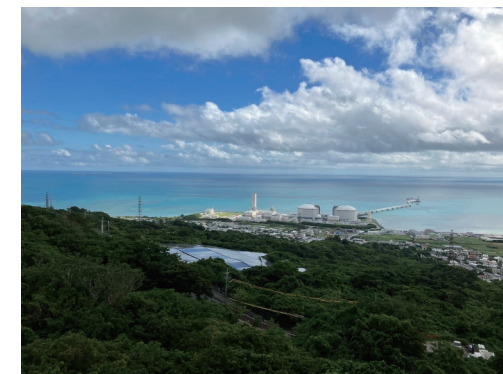
参加者の目をひいた中腹にある太陽光パネル
