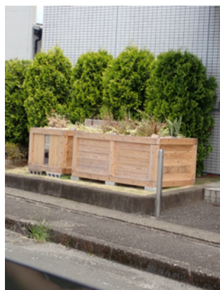
あさぎり町内に設置された雨庭
