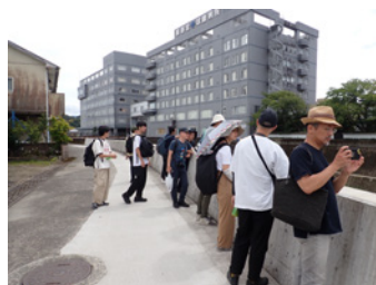
破堤後に修復された山田川の護岸
