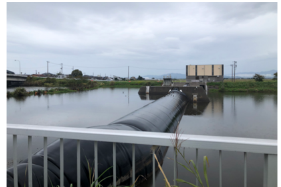
椋堰のゴム引布製起伏堰
