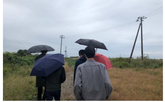
「戻されつつある潟」内に残された電線と電柱
