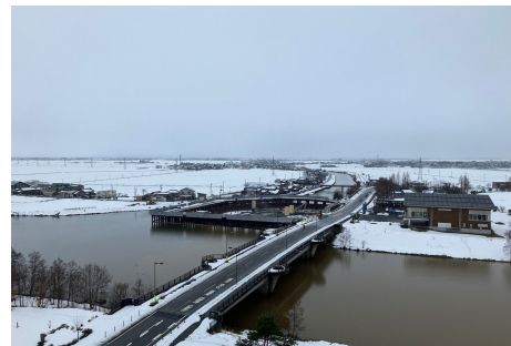
★建設中の福島潟水門(写真中央)と、福島潟放水路(写真右手方向に排水)
