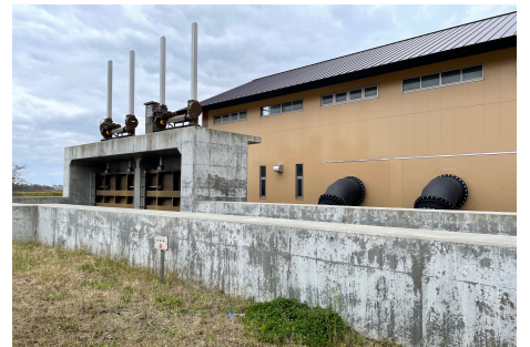
★万十郎川排水機場の様子（以前撮影したもの）
