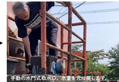
手動の水門式取水口。水量を元に戻します。
