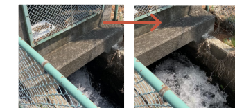
手動の水門式取水口。水量を元に戻します。
