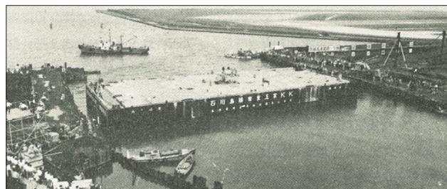
図 4.6 1号羽田線 羽田トンネル (工事中) 16)
