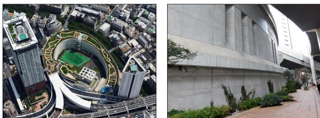
図 4.5 3号渋谷線 大橋ジャンクション (左:上空写真 45) , 右:壁面)
