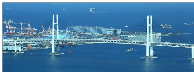
図 4.7 高速湾岸線 横浜ベイブリッジ 外観 48)
