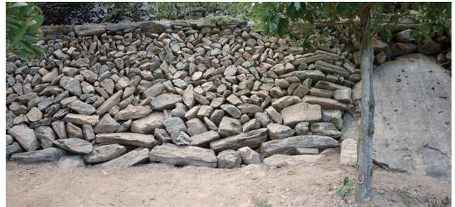
図-12 修復による石積みの変化
