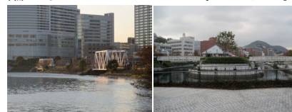
fig.6-2 [歴史的文脈を活かした複数橋梁による風景の創出] 汽車道橋梁群 [一括デザインを活かした複数橋梁による風景の創出] うみでらし橋、あじさい橋
