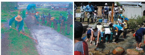
図 5.5 性質の異なる整備の様子(例) (左) 道路の舗装整備 23) (右) ホタル水路の整備 24)
