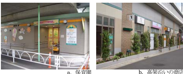
図-13 小田急線の商業施設
