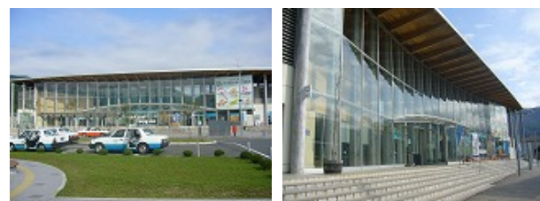
図8. 田沢湖駅駅舎の外観
