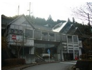
図3. 栃木県川治温泉駅
