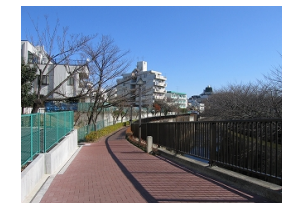
図 5-15 石神井川遊歩道
