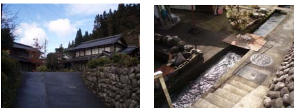
図 7.中坪にある住居と用水路
