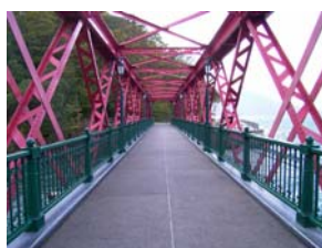
図 1 修景後の橋面の様子 撮影：著者，2005.10
