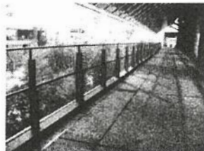
図-8 品川東口エリアの ペDESTリアンデッキ
